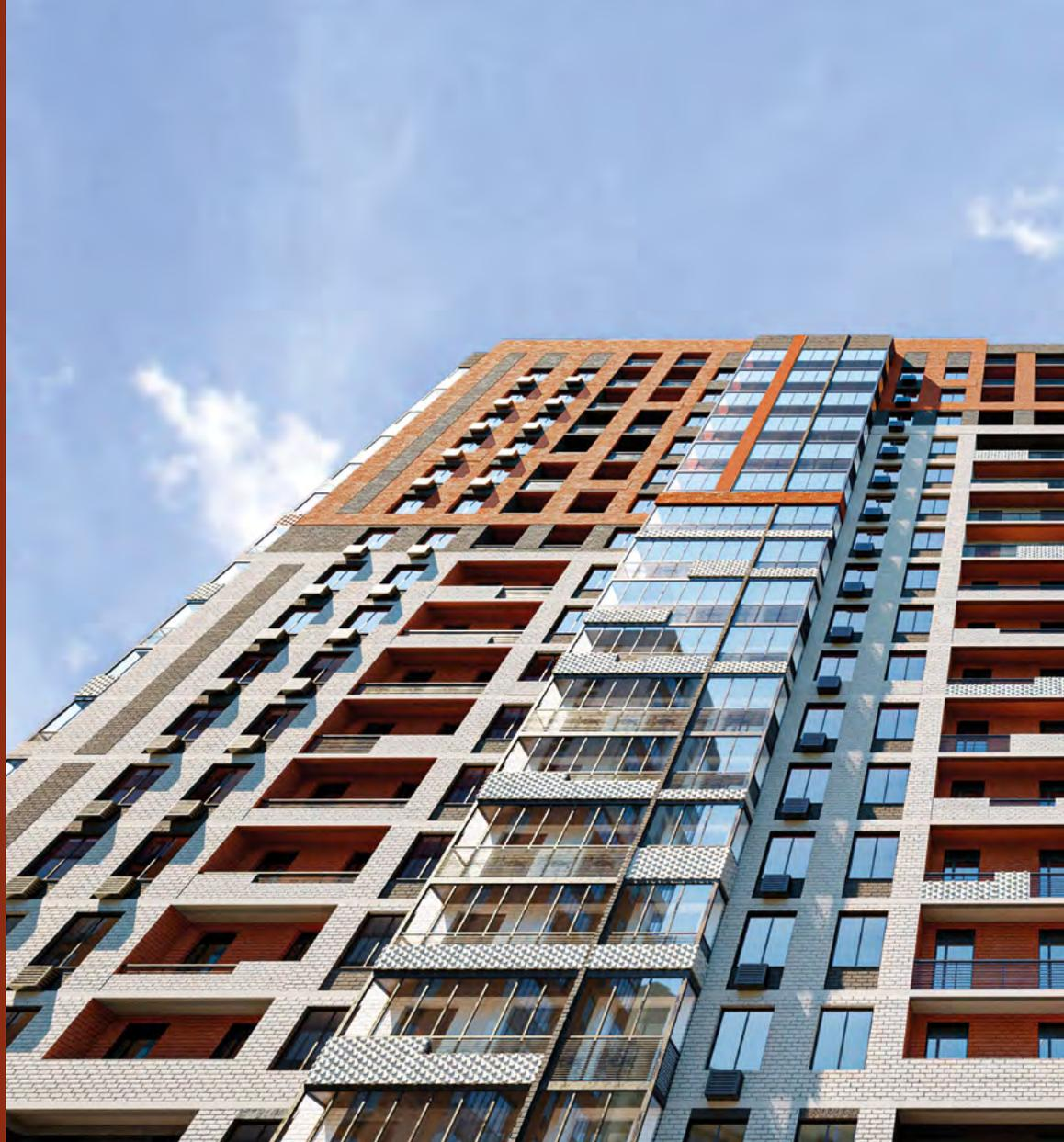
Возводимые по монолитно-кирпичной технологии семнадцатипятиэтажные здания отличаются применением базальтового утеплителя и воздушной прослойкой, гарантирующих высокую тепло- и шумоизоляцию, долговечность, энергоэффективность, экологичность и современный внешний вид. Фасады выполнены в спокойной цветовой гамме и сочетают различные фактуры и декоративные элементы.
